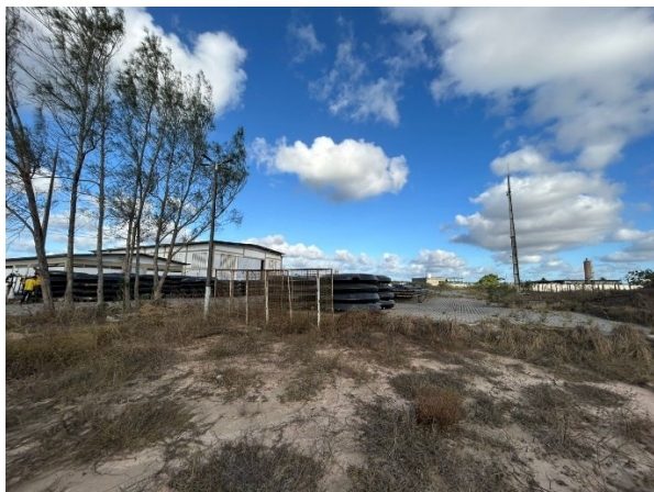
Figura 11 - Visão do Pátio de Estocagem
